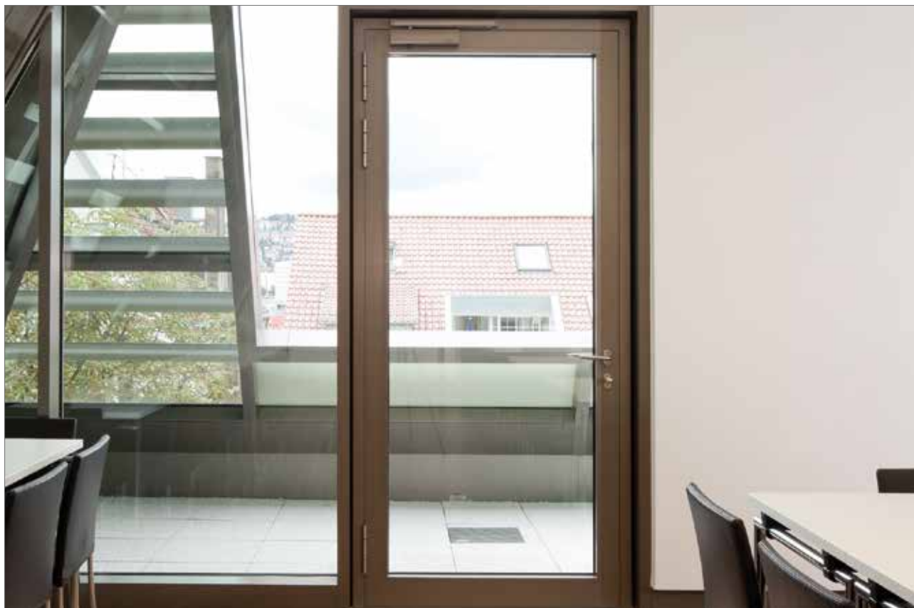
TS 5000 avec bras à coulisse T-Stop, bâtiments administratifs de l'Eglise catholique, Stuttgart, Allemagne (photo : Dirk Wilhelmy)
